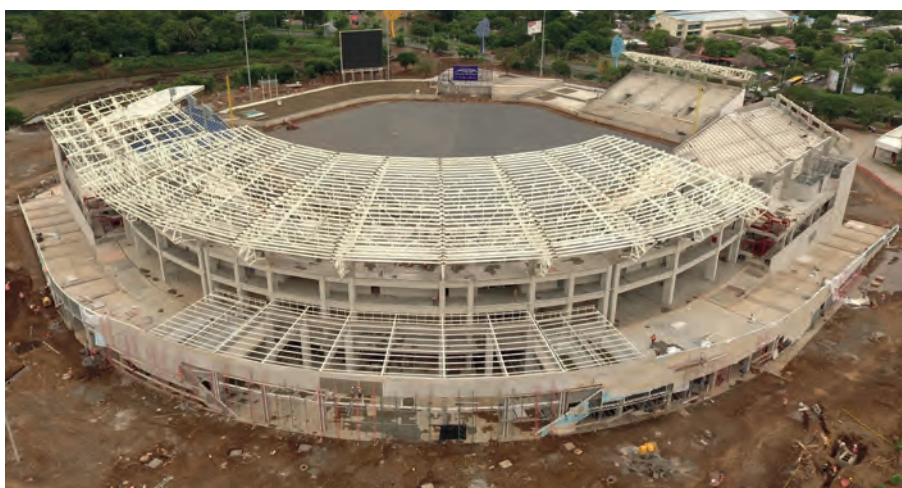
Obras como la del estadio de beisbol Dennis Martínez animan la construcción en Nicaragua.
