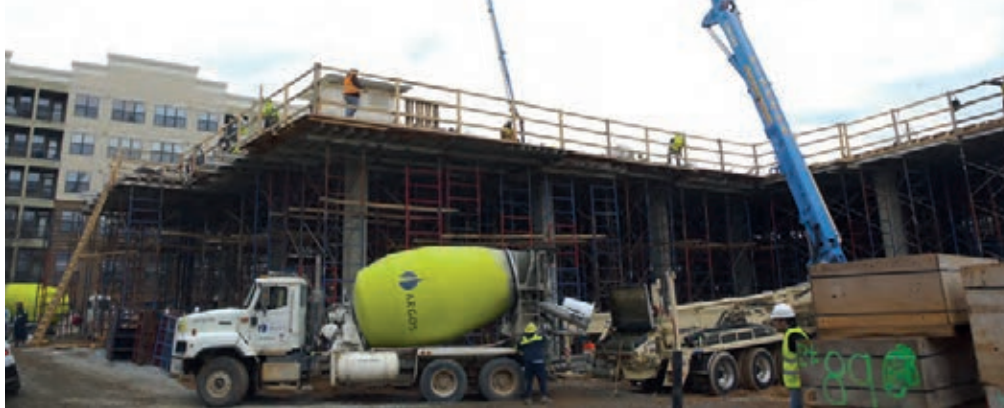
Aquí, el CO 2 ya mezclado al concreto es utilizado en la construcción de un edificio en Atlanta.
