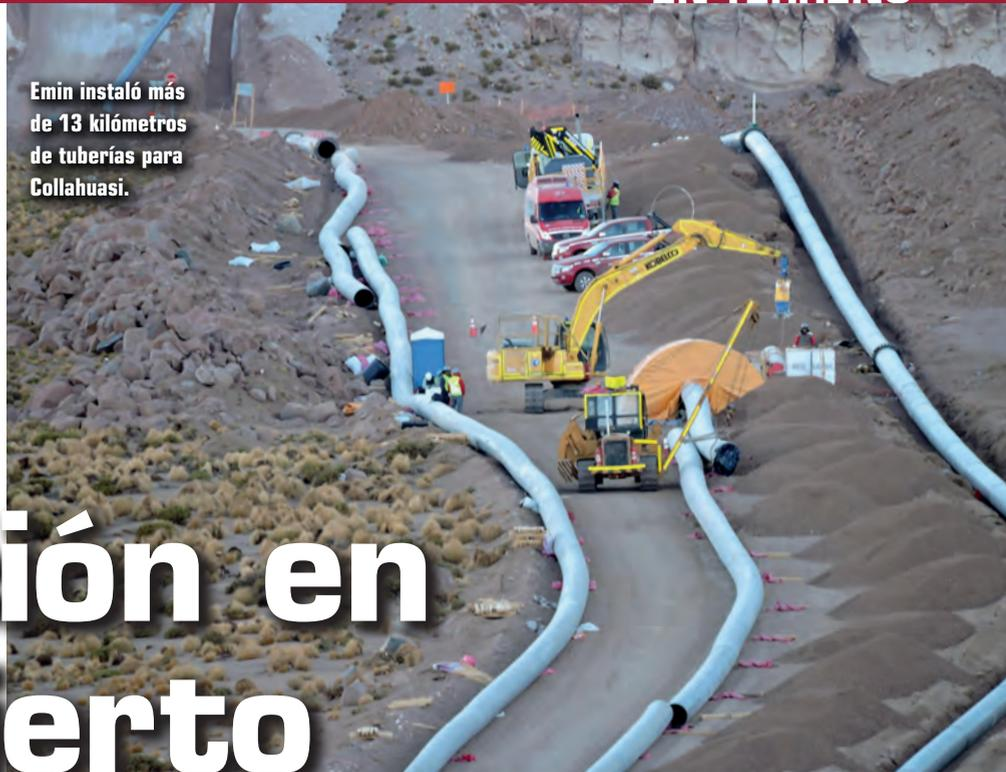
**U**n jugador importante en el espacio minero chileno descubrió las ventajas específicas relacionadas con la elevación por vacío como método para manejar tuberías de polietileno y acero de alta densidad.
