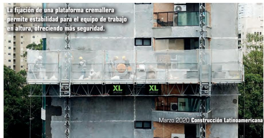
La fijación de una plataforma cremallera permite estabilidad para el equipo de trabajo en altura, ofreciendo más seguridad.
