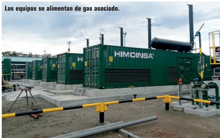
proceso de extracción del crudo, convirtiendo residuos dañinos para el medio ambiente en energía), en contenedor tropicalizado, con ventilación especial y protección ante condiciones climatológicas extremas. Estos generadores han sido diseñados para trabajar en paralelo con otros grupos electrógenos diésel”, señalan desde la empresa. ■
